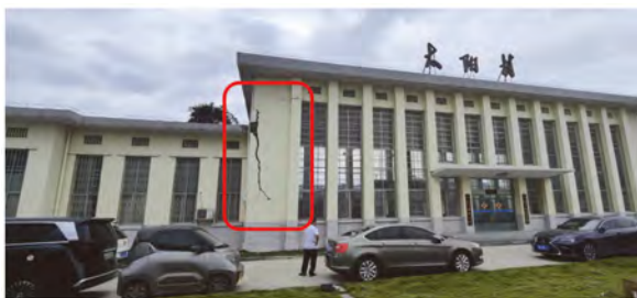
图8 受到严重破坏的太阳火车站
