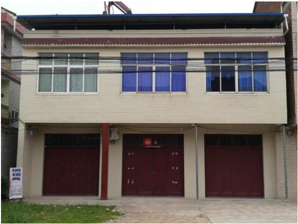
图7 外纵墙不连续的多层砌体农居建筑
