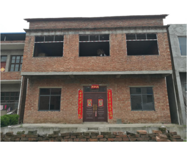
图7 外纵墙不连续的多层砌体农居建筑
