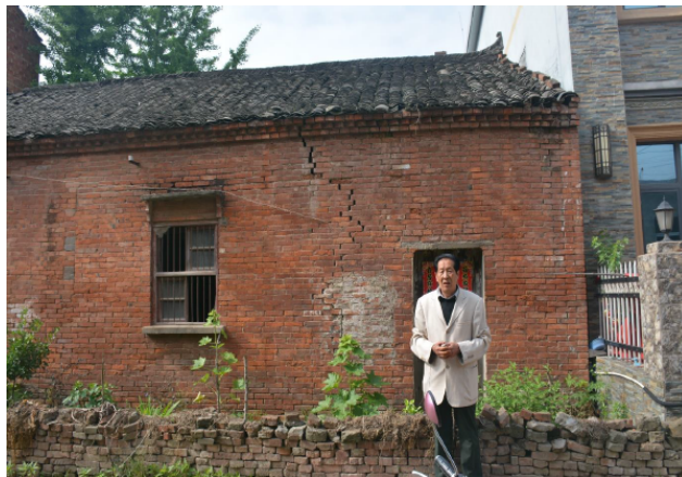
图10 墙体裂缝
