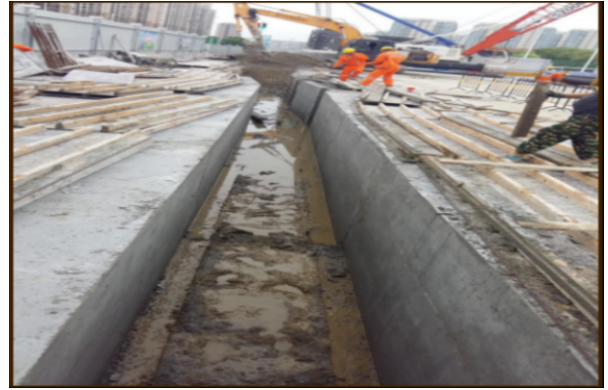
图8 现场地连墙成槽施工
