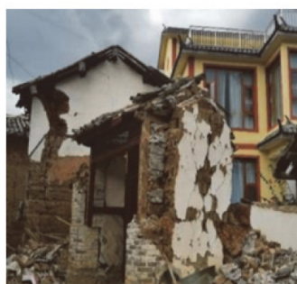
图5 主体局部垮塌 Fig.5 Local collapse of main body
