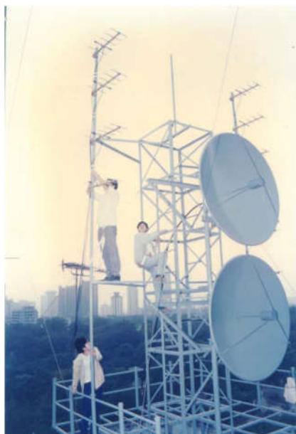
图 7 珠江台网接收中心天线安装调试
