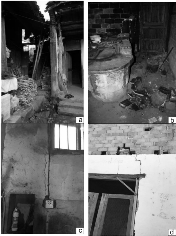
a.方前镇乌岩坑村危旧房屋屋瓦掉落；b.方前镇乌岩坑村危旧房屋灶台烟道损坏 c.尚湖镇岭干村砌体房屋老裂缝加宽加长；d.方前镇西岙村砌体房屋老裂缝加宽加长
