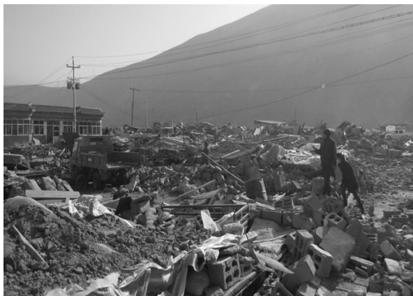
图1 玉树地震结古镇未经设防的建筑破坏严重
