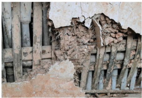
竹编夹泥墙围护墙
