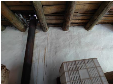
Ⅵ度区木梁轻微裂缝
