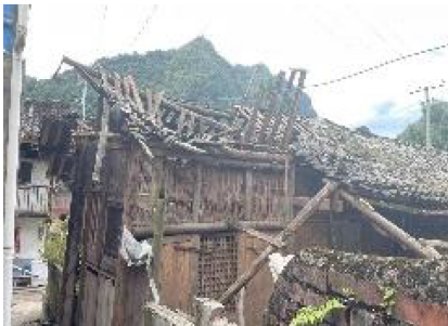
Ⅷ度区木构架局部倒塌
