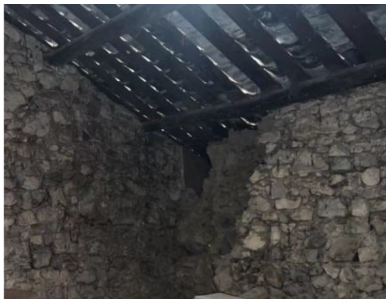
Ⅶ度区墙体局部分层剥落
