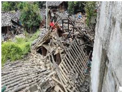
Ⅸ度区木构架完全倒塌
