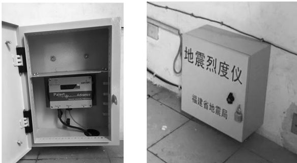
图 7 安装防护机箱
