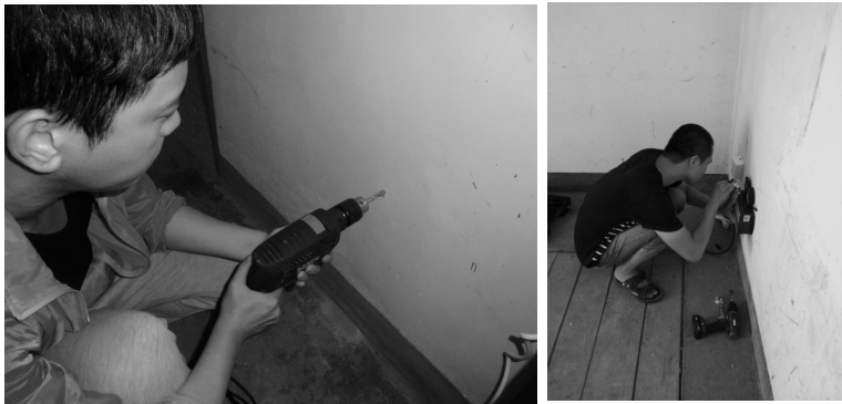
图 5 冲击钻取孔、仪器调水平并锁固
