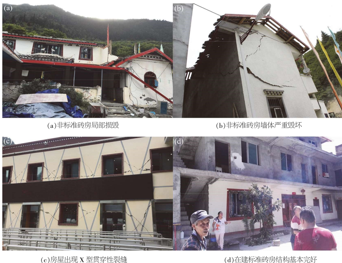
图4 九寨沟地震灾区砖混结构房屋震害特征
