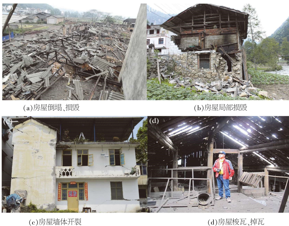
图5 芦山地震灾区简易结构房屋震害特征
