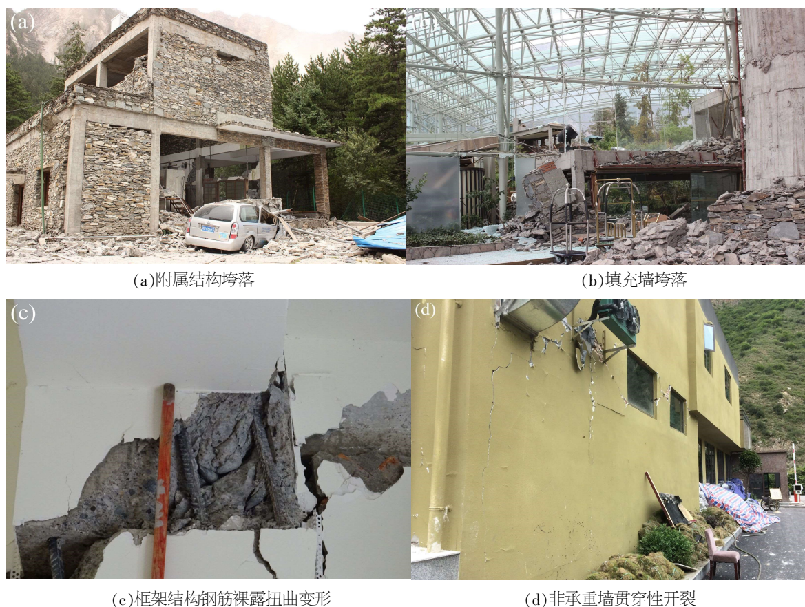
图2 九寨沟地震灾区框架结构房屋震害特征
