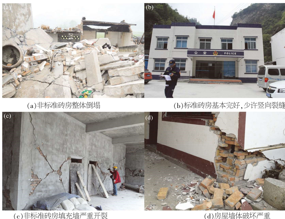
图 3 芦山地震灾区砖混结构房屋震害特征
