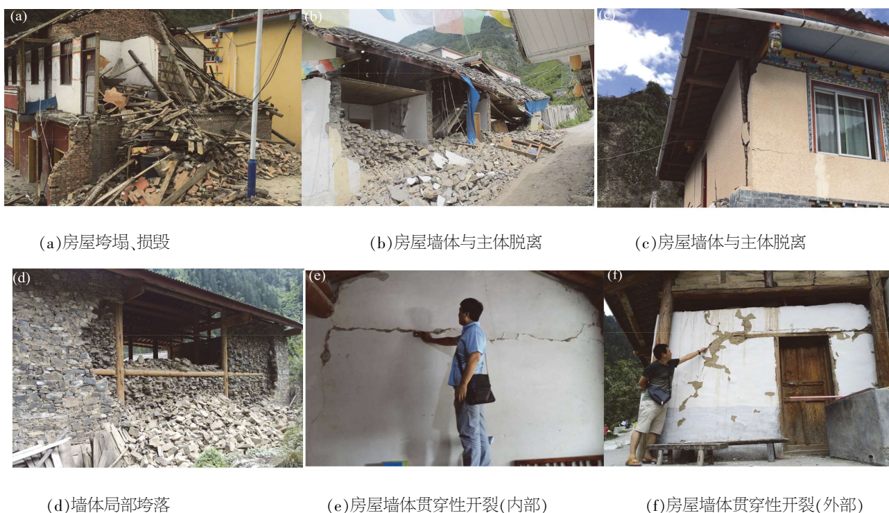
图6 九寨沟地震灾区简易结构房屋震害特征
