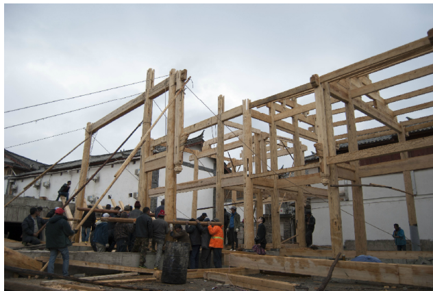
图1 木构架施工过程
