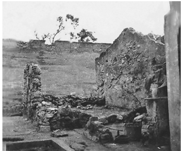
照片 6 汕头市达豪镇毛石砌筑的民房倒毁。(广东省地震局原广州地震大队，摄于 1972 年)
