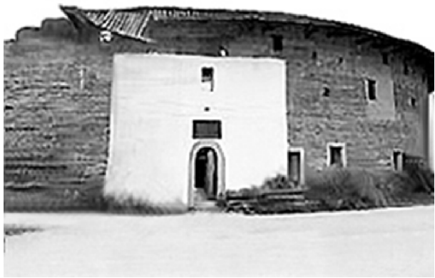
照片 9 饶平县许多土楼围墙多处震裂崩落或楼盖损坏。 (广东省地震局潮汕地震台站，陈诗安、魏先洁于 1986 年提供)
