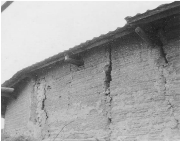
照片 8 联饶镇高厝铺土楼园寨围墙多处震裂。 (广东省地震局原广州地震大队，摄于 1972 年)
