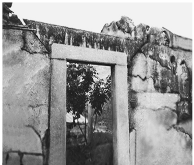
照片 7 澄海县上华镇冠山村厝宅土墙开裂屋顶盖坍塌。(广东省地震局原广州地震大队，摄于 1972 年)
