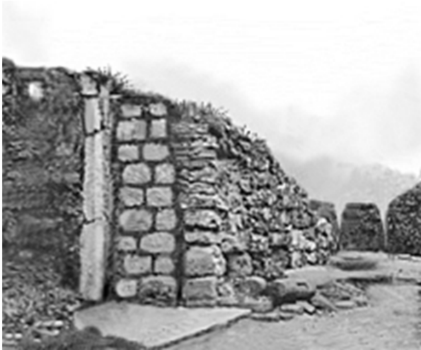
照片 4 饶平县柘林镇村落厝宅几乎都朝北西向倾倒或坍塌。(广东省地震局潮汕地震台站，陈诗安、魏先洁于 1986 年提供)
