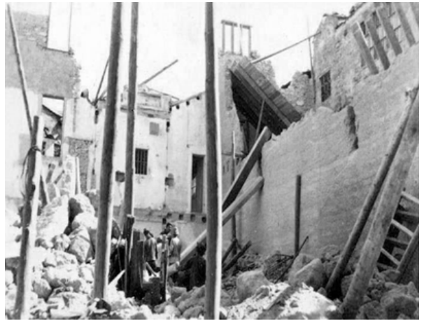
照片 5 1918 年南澳大地震，汕头市崎碌教堂附近楼房墙体折裂崩断，屋顶坍塌。
