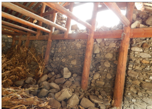
图 2 石木结构房屋外墙部分倒塌主体结构基本完好
