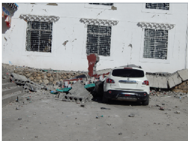
图 4 康定木雅祖庆学校砖混结构墙体垮塌
