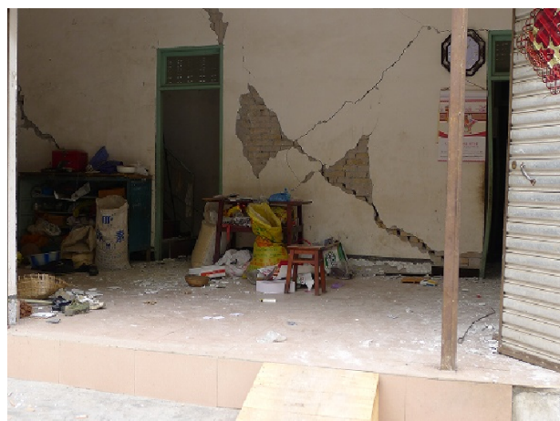
图 5 砖混结构房屋 X 型裂缝贯通
