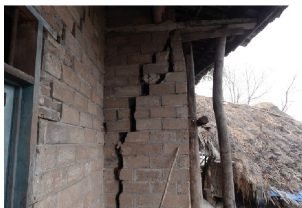
图 3 砖木结构房屋墙体开裂
