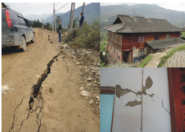
左为路面开裂沉陷, 右上为木房瓦片滑落, 右下为砖房墙体开裂
